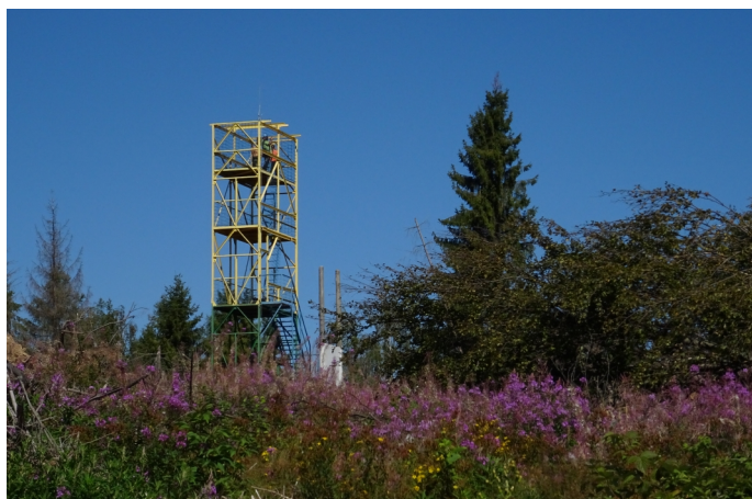
Rozhľadňa na Tureckej (954 m)
